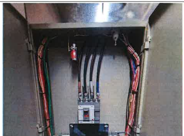
내용 : 배전함 내 소방설비 설치. 양호
