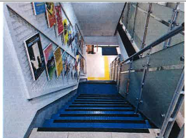
내용 : 전 층 계단 미끄럼 방지설비 구비. 양호
