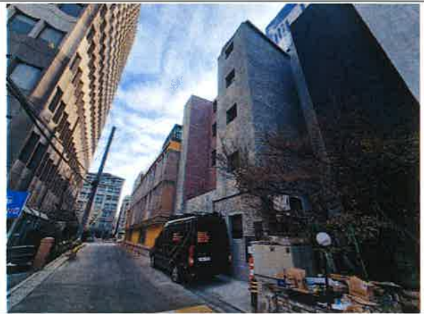
내용 : 건물 외벽 균열, 변형 없음. 양호
