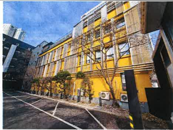
내용 : 건물 외벽 균열, 변형 없음. 양호
