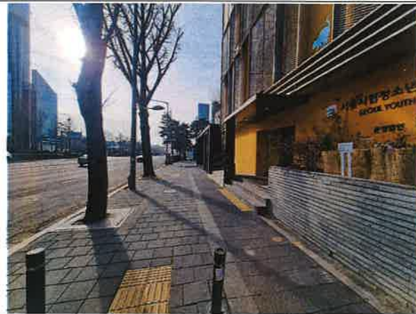
내용 : 건물 외벽 균열, 변형 없음. 양호
