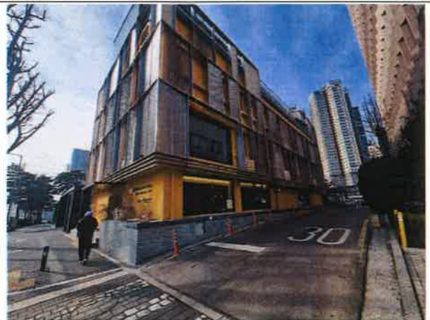
내용 : 건물 외벽 균열, 변형 없음. 양호
