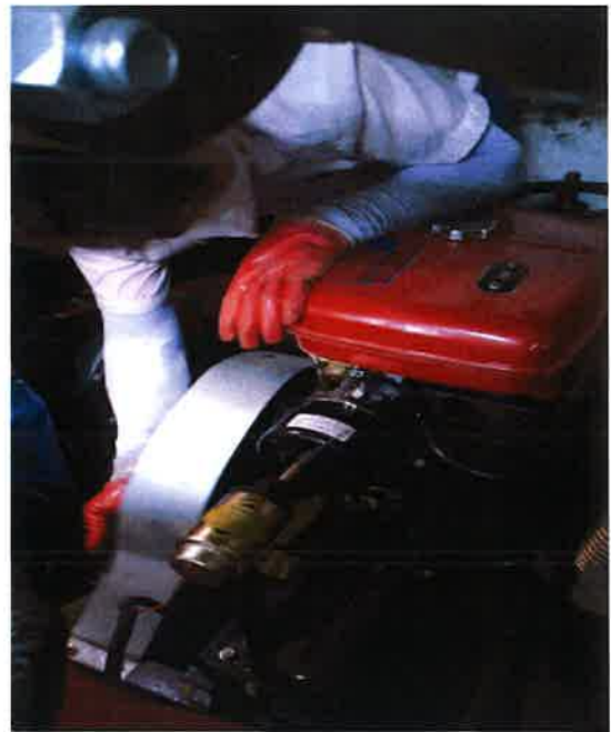
소방엔지펌프 카브레타 교체후
